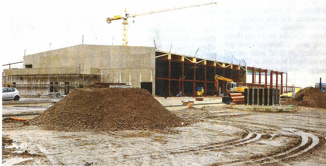
So sah das Sportzentrum gestern aus – die Arbeiten sind weit fortgeschritten.
